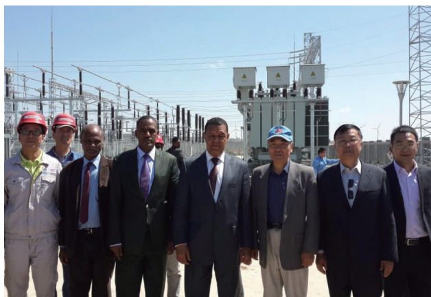
图 11 时任埃塞俄比亚总统穆拉图视察二期项目现场 （来源：中国商务部网站）
