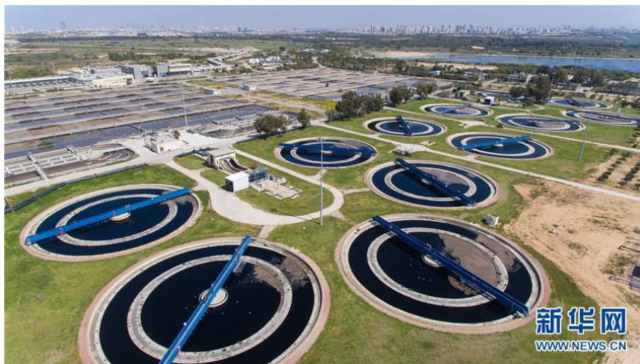
图 4-6 沙夫丹（Shafdan）污水处理厂（图片来源：新华网）
