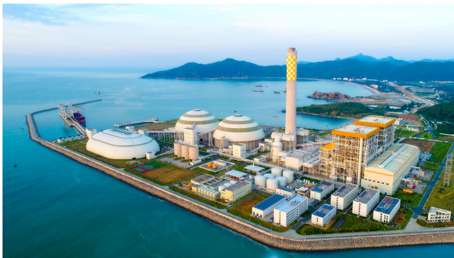
图 3-11 华润海丰污泥焚烧项目
