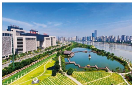
(d) 福州市东部办公区水源热泵项目
