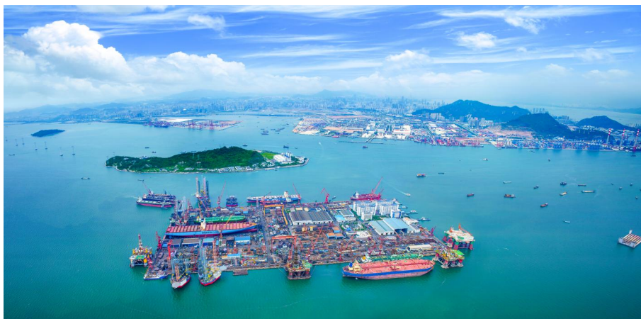
图 3-9 采用高压水刀代替传统钢砂对船壳进行除锈的友联修船基地
