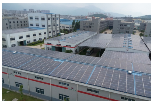
(c) 福建省建科院太阳能光伏项目
