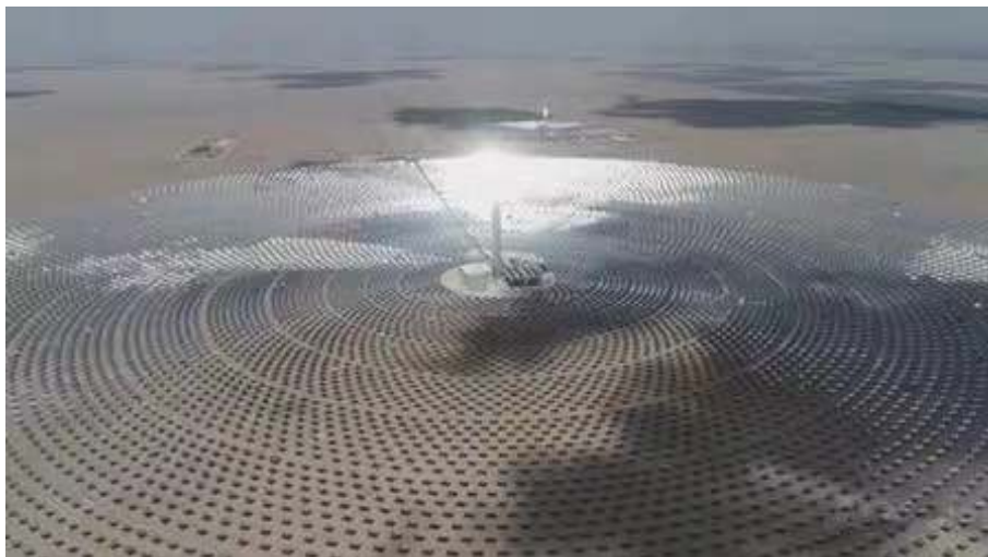
图 5-6 首航节能敦煌 100 兆瓦熔盐塔式光热发电站
