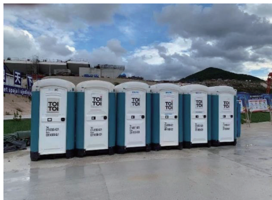
图 47 施工现场设置可回收的移动厕所
