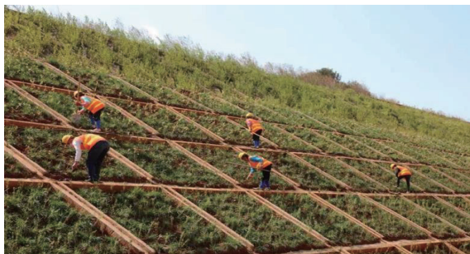
图 6 绿化工程施工
