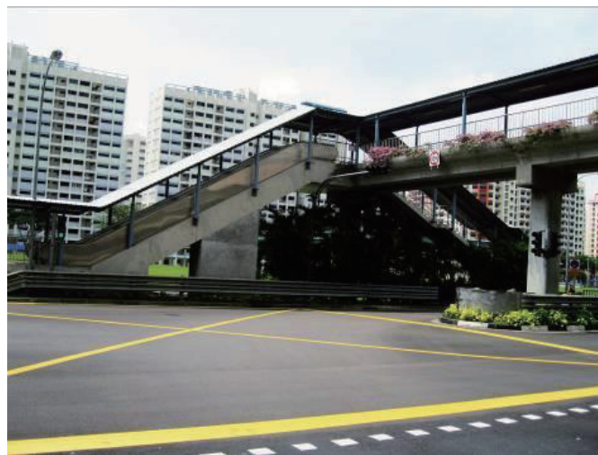
图 83 公交枢纽站外人行天桥
