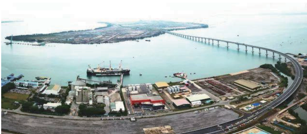
图 27 PMB 跨海大桥
