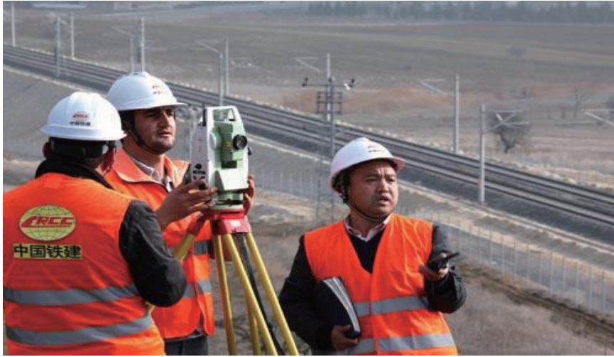
图 4 安伊高铁进行隧道建设测量
