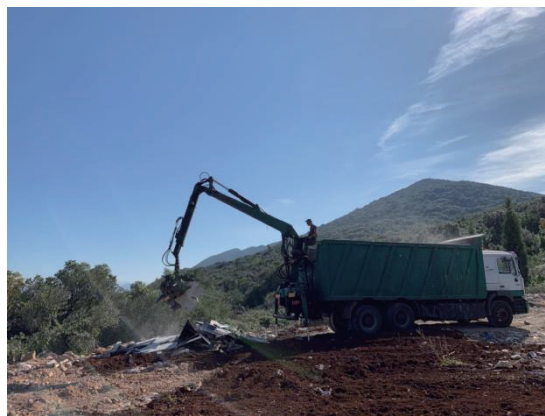
图 46 分类存放，专业公司集中处理建筑垃圾
