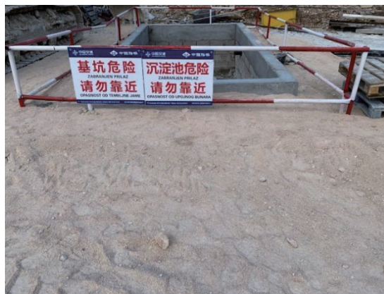
图 41 设置四级污水沉淀池
