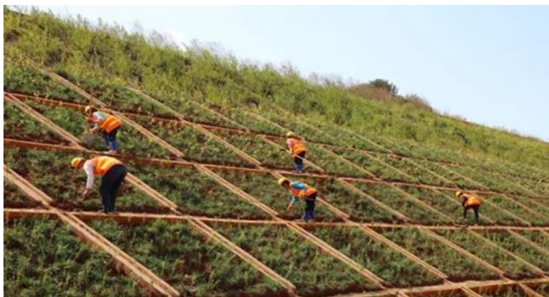
图 10.5 中老铁路绿化工程施工
