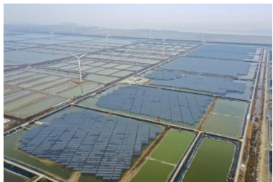
图 9.1 江苏南通市“渔光互补”光伏发电项目 79
