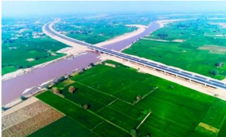
图 10.6 PKM高速公路项目远景
