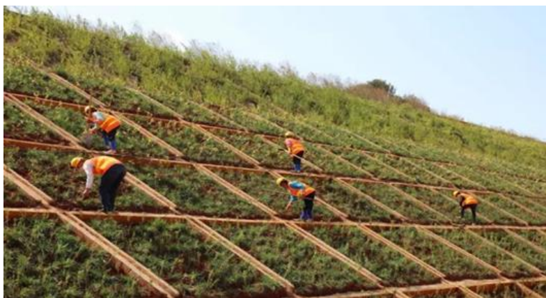
图 10.5 中老铁路绿化工程施工
