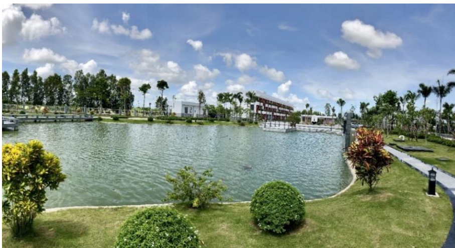
图 5-3 越南芹苴垃圾焚烧发电厂厂区
