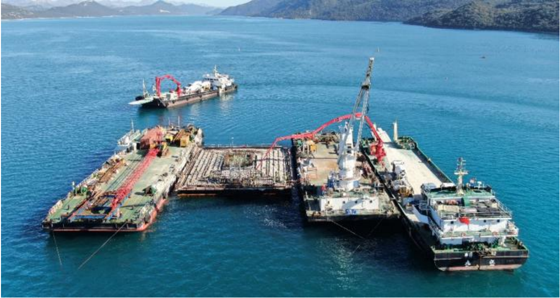
图 4-12 施工主材及设备均符合 CE 认证
