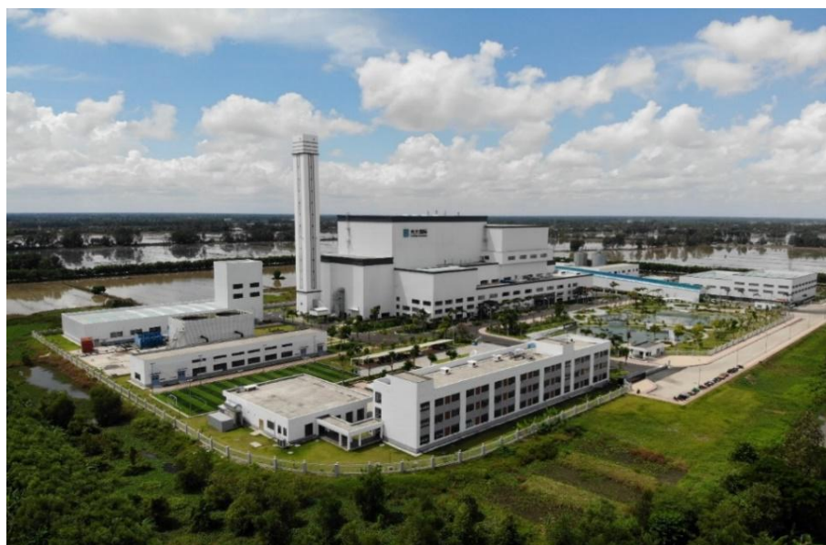
图 5-1 越南芹苴垃圾焚烧发电厂全景图
