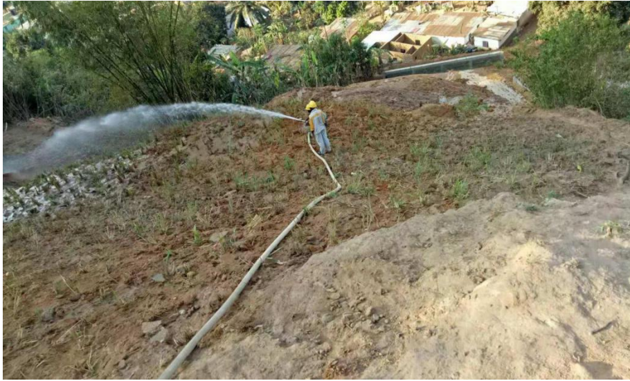
图 3-4 利用废旧沥青砼对陡坡路段进行雨水冲刷防护
