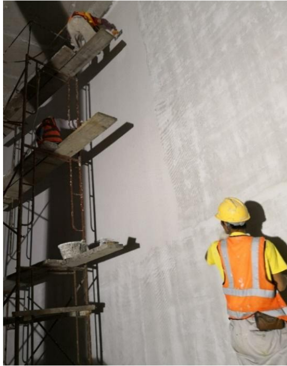
图 3-3 Sika 防水涂层施工
