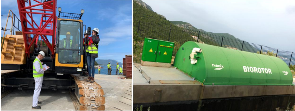
图 4-11 对施工设备进行第三方检测和生活区污水处理装置
