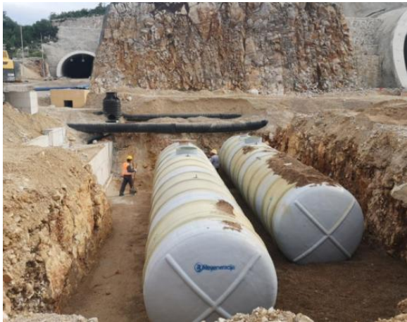
(c) 油水分离器安装
