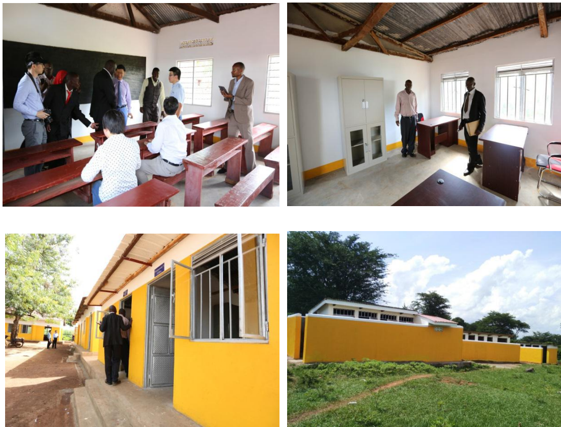
图 8-18 维修后的 NAKAKANDWA RC 小学
