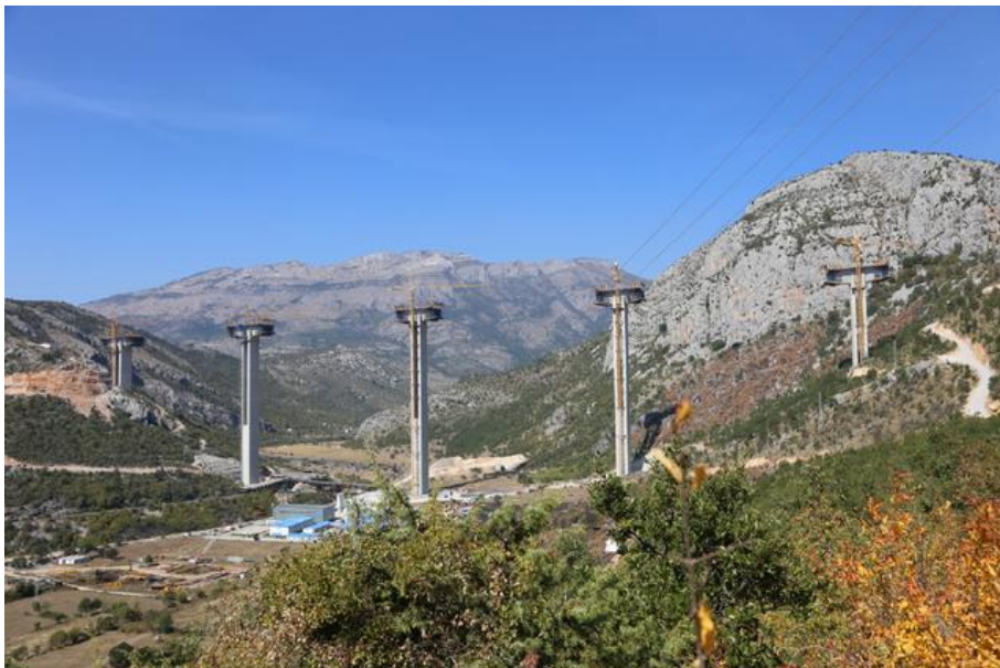
图 4-2 莫拉契查大桥施工现场（2018 年）
