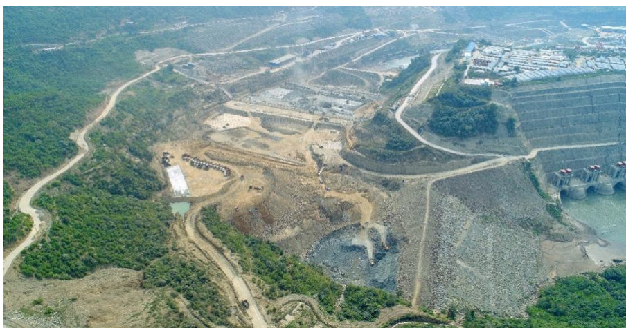
图 2-3 坝区建设场景
