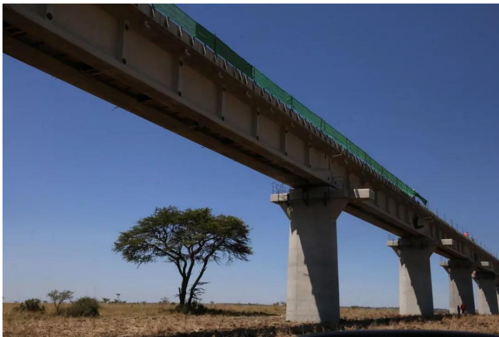
图 1-4 内罗毕公园大桥
