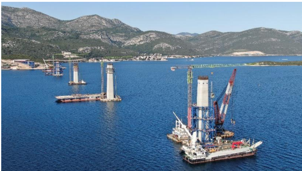
图 4-7 大桥施工现场
