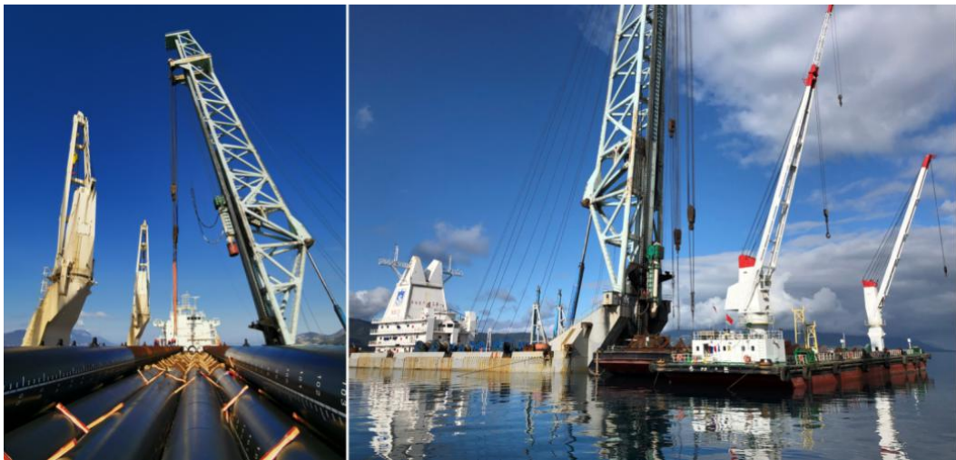
图 4-8 钢管桩施工现场（左为钢管桩调运，右为钢管桩打设）
