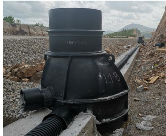
(b) 检查井和排水管连接图
