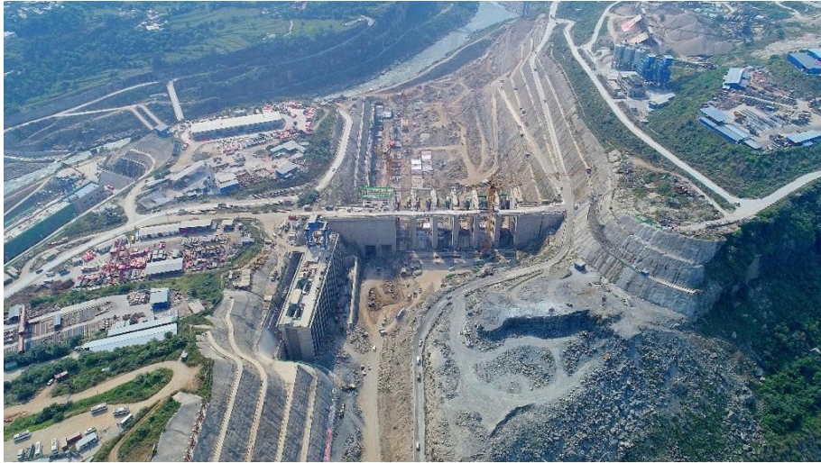
图 2-2 溢洪道建设情况
