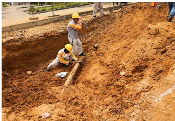
图 3-8 帮助当地政府部门修复损坏的既有供水管道
